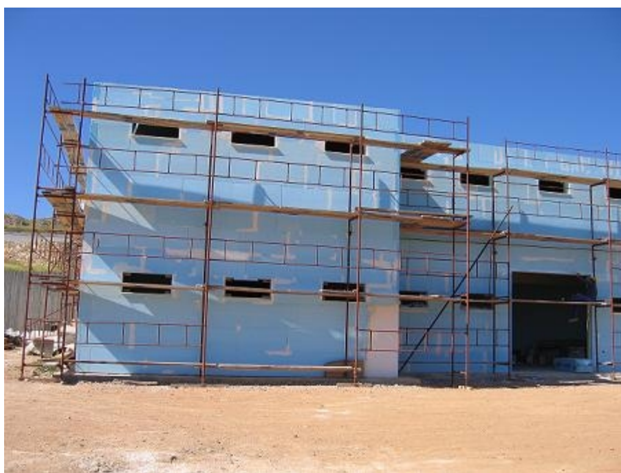
Εικόνα 2.3.2 Εξωτερική θερμομόνωση με χρήση εξηλασμένης πολυστερίνης
