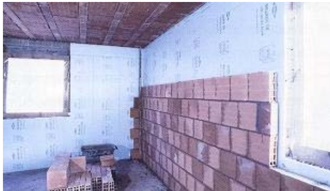
Εικόνα 2.3.3 Θερμομόνωση τοιχοποιίας στο διάκενο μεταξύ δυο τοίχων
