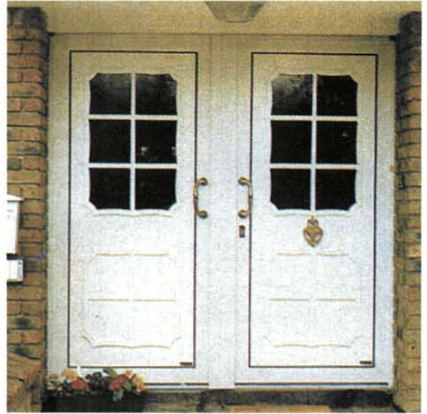
Σχ. 10.6κ. Εξώπορτες από PVC. Η διατομή τους είναι κυψελωτή με εσωτερική χαλύβδινη ενίσχυση.
