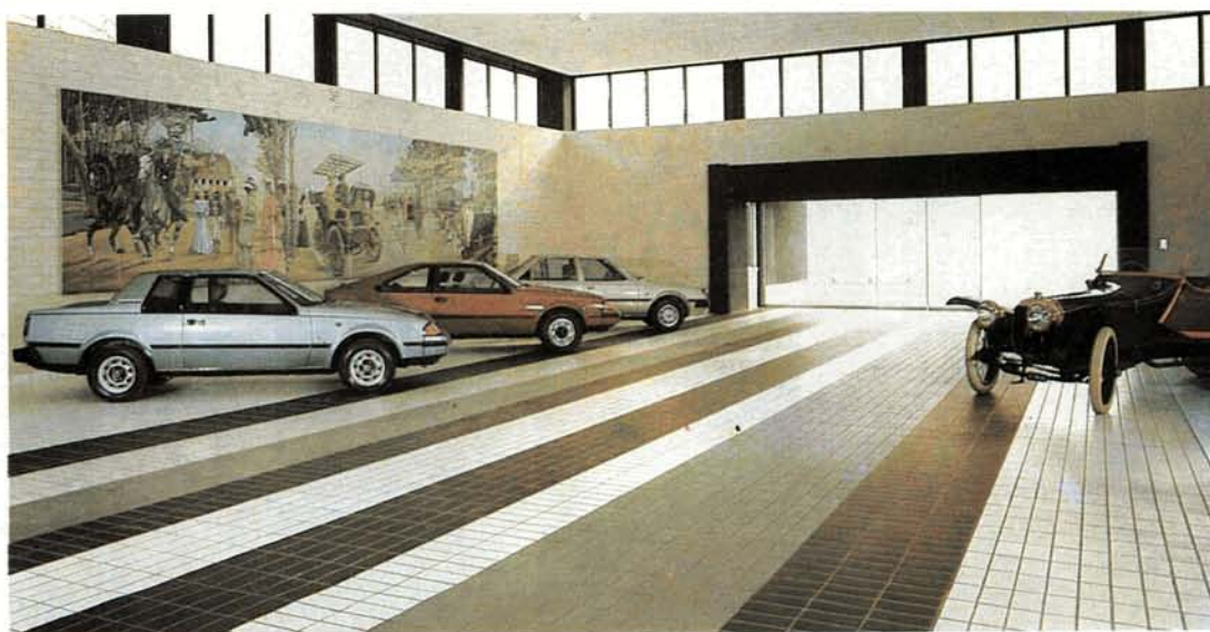
Σχ. 6.2λδ. Δάπεδο σταθμού αυτοκινήτων με κεραμικά πλακάκια που διακρίνονται για τη μεγάλη μηχανική αντοχή τους, την μεγάλη διάρκεια ζωής τους και την εξαιρετική αισθητική εμφάνισή τους.
