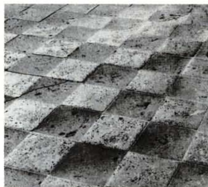
Σχ. 6.2λστ. Ανομοιόμορφη φθορά πλακών από άργιλο, που οφείλεται σε μεγάλες τριβές και σε διαφορετική σύνθεση της αργίλου στις λευκές και μαύρες πλάκες.
