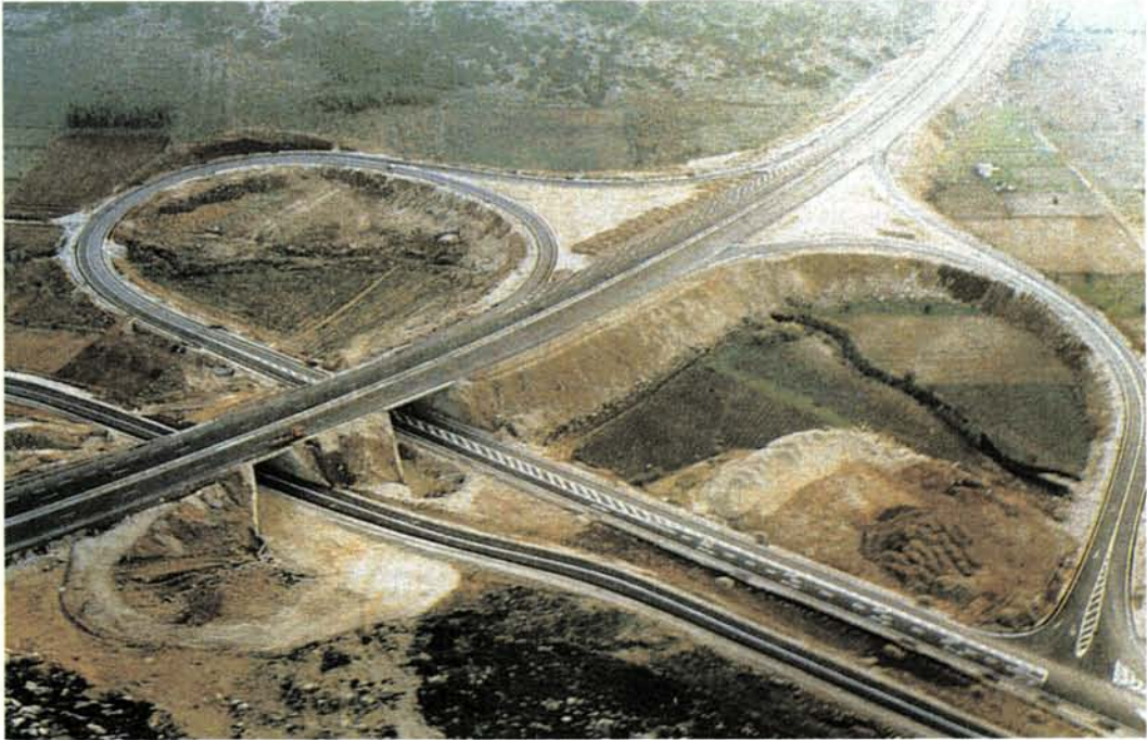
Σχ. 1.1η. Ανισόπεδος κόμβος στον εθνικό αυτοκινητόδρομο Κορίνθου-Τριπόλεως.
