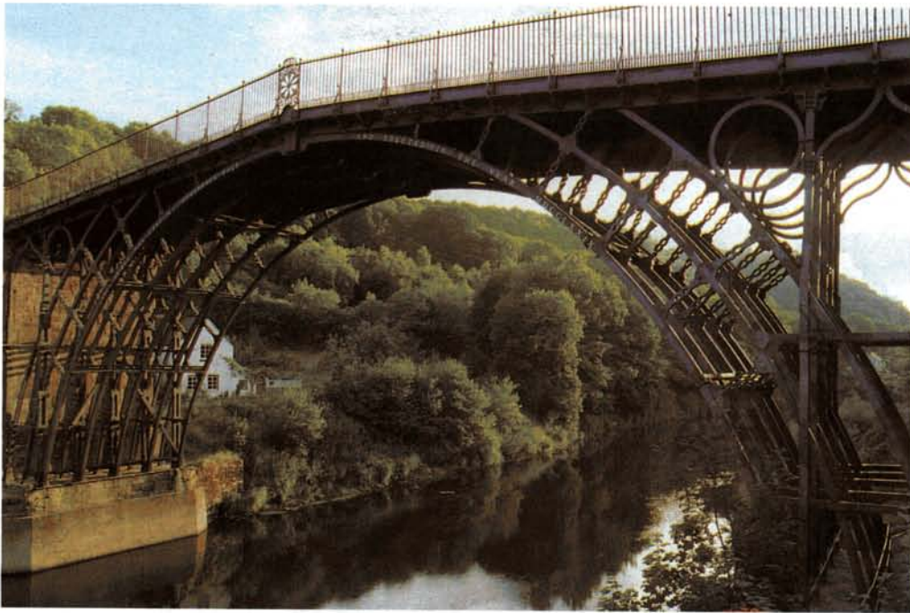
Σχ. 8.1α. Η πρώτη χυτοσιδερένια γέφυρα. Κατασκευάστηκε το 1779.
