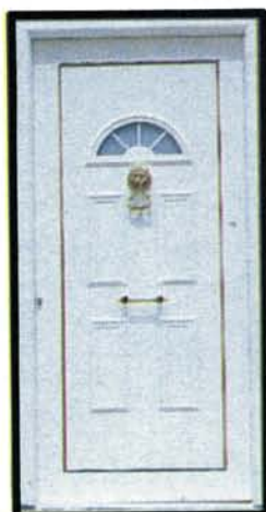
Σχ. 8.6ιστ. Από φύλλα αλουμινίου κατασκευάζονται φύλλα θυρών που στηρίζονται σε πλαίσιο από αλουμίνιο ή από χάλυβα.
