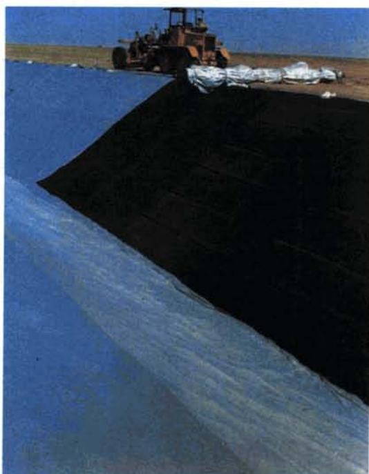
Σχ. 12.4ια. Γεώφρασμα από μη υφαντές πολυεστερικές ίνες, για την προστασία των πρανών μεγάλων αρδευτικών διορύγων.
