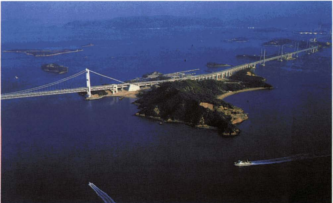
Σχ. 8.1στ. Η μεγάλη γέφυρα του Seto στην Ιαπωνία. Τα περισσότερα τμήματά της είναι κρεμαστές γέφυρες.
