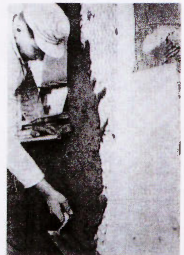
Εικ.211 Εφαρμογή θερμομονωτικού σοβά.
